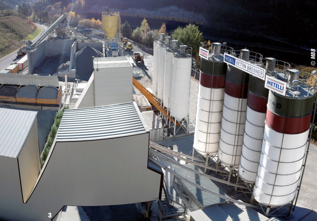
1,2 . Carico di betoniere nel cantiere Mules 2-3
